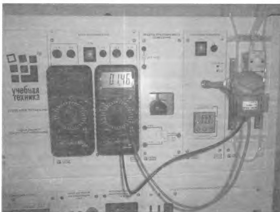
Рисунок 2 – Испытание термоэлектрического преобразователя
